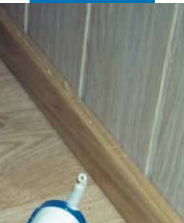
Drewniana listwa przypodłogowa przyklejona za pomocą Ultrabond Eco 575
