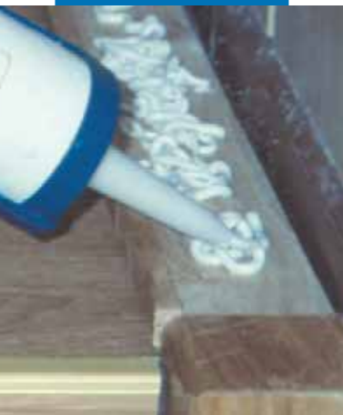
Klejenie drewnianej listwy przypodłogowej z użyciem Ultrabond Eco 575
