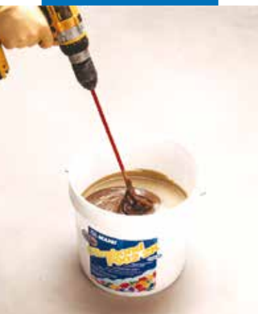
Mieszanie kleju Ultrabond P902 2K mieszadłem wolnoobrotowym
