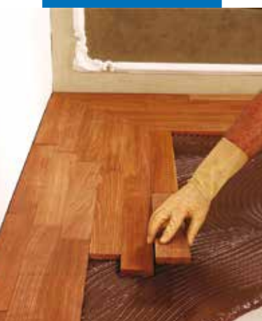
Montaż lamelek
