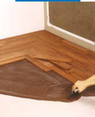
Rozprowadzanie kleju przy użyciu zębatej szpachelki
