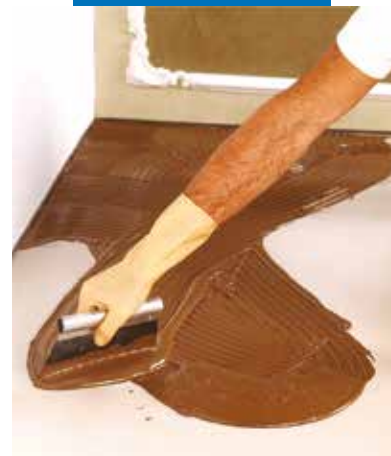
Rozprowadzenie kleju na podłozie
